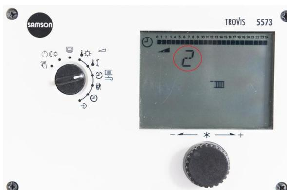
Wenn Sie den Bedienknopf gegen den Uhrzeigersinn drehen bis die „1“ wieder zu sehen ist, können Sie oben im Display nun die eingestellten Nutzungszeiten für die Heizung für den Wochentag Montag mit zwei verschiedenen Zeitintervallen als Balkenanzeige ablesen.
