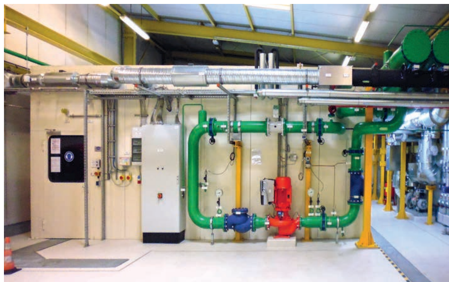
Die neue Wärmepumpen-Anlage sorgt für mehr Effektivität bei der Wärmeerzeugung.
