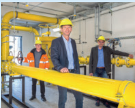
Stadtwerke-Vorstandsvorsitzender Oliver Brünnich (m.) nahm zusammen mit Lars-Ole Harms (r.), Leiter der Hauptabteilung Gas, und Nils Lemmrich, Abteilungsleiter Gas-Betrieb, die neue Gas-Übernahmestation in Betrieb.
