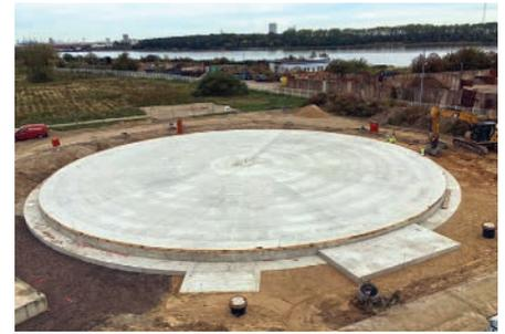
Die Bodenplatte wird danach gegossen und die notwendige Armierung für den weiteren Aufbau gesetzt. Der Boden ist nun bereit.
