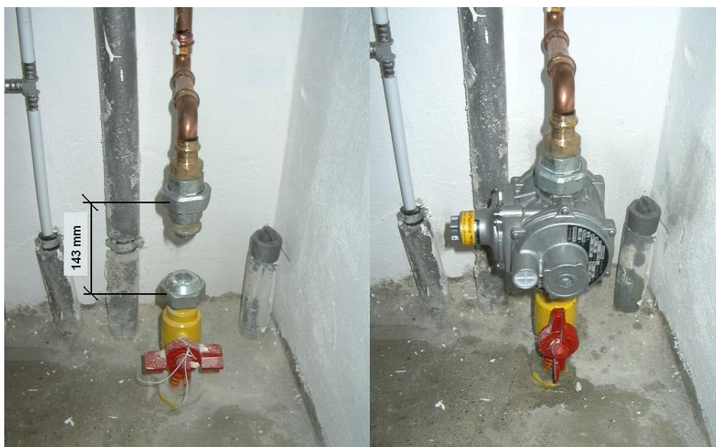
Bild 1: Abstandsmaß für MD-Netzanschlüsse
